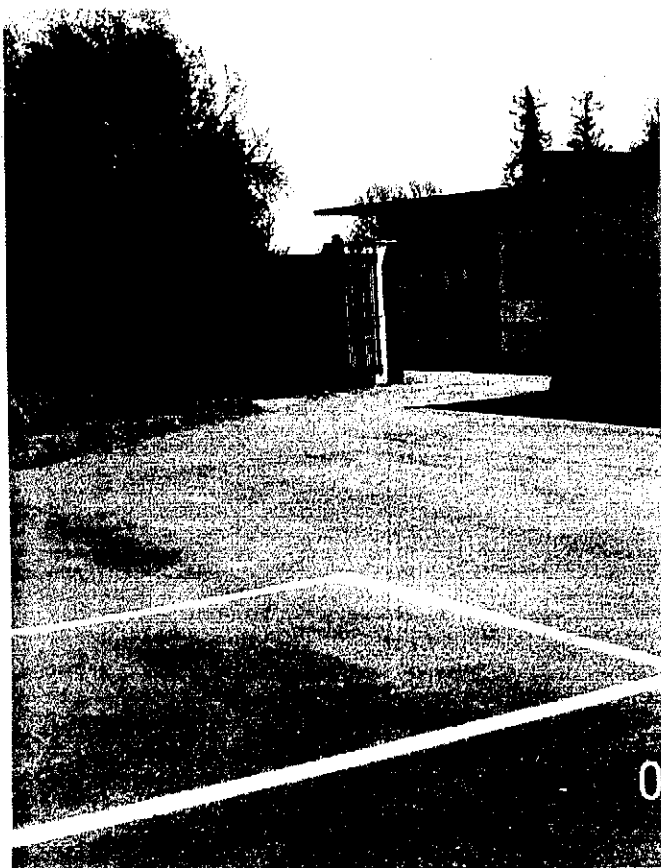
ACCESSO NORD ATTUALE FOTO 3
